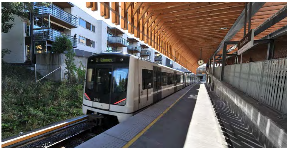
Oppgradering av Kolsåsbanen og nye T-banetrog inngår i Oslopakke 3. Foto Knut Opeide.
