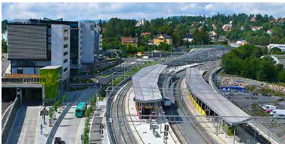
Ny Lysaker stasjon (2009) med fire spor til plattform og nye dobbeltspor Lysaker – Sandvika (2011) har gitt økt togkapasitet. Foto: Jernbaneverket
